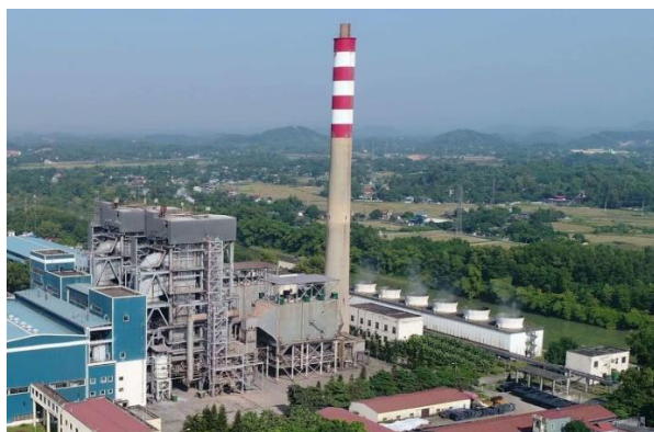
Hình 29. Công ty nhiệt điện Cao Ngạn
