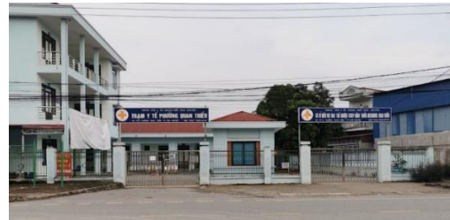
Hình 8. Trạm y tế phường Quan Triều
